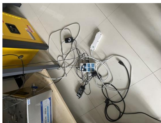
第三实验楼 309—接线板直接放置地面使用，负责人罗晶晶（左图为初查、右图为复查）
