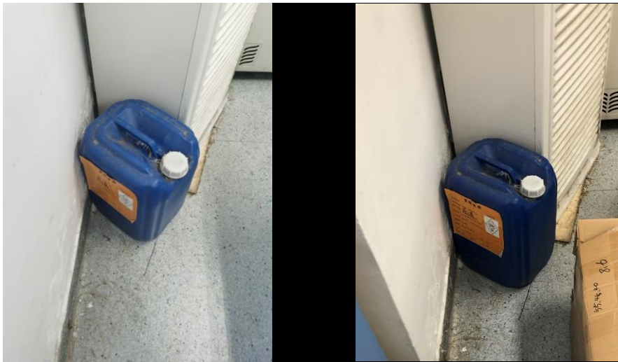
理科楼 A317-319—废液桶未配备防漏托盘，无警示标识和警示带，负责人肖进（左图为初查，右图为复查）
